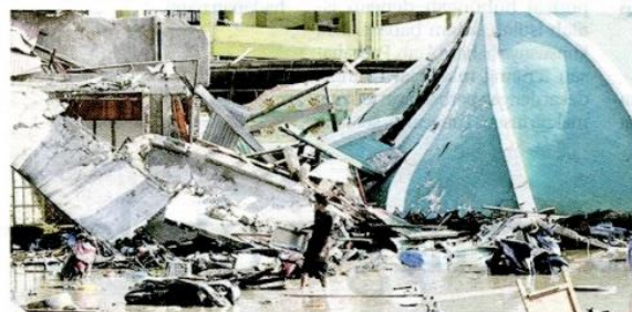
Pandangan kawasan tsunami yang dahsyat di pantai Talise, Palu, Sulawesi Tengah, Indonesia.
