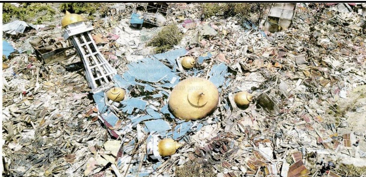
Pandangan dari udara yang diambil menunjukkan masjid yang roboh akibat gempa bumi dan kawasan sekitarnya di Palu, Sulawesi Tengah, Indonesia.
