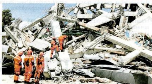
Penyelamat Indonesia melakukan tugas menyelamatkan di Hotel Roa Roa, Palu, Sulawesi Tengah, Indonesia yang runtuh.
